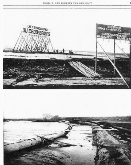
Het opspuiten van terreinen ten behoeve der fabriek van de fa. Du Croo & Brauns te Weesp.
