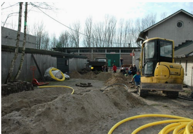
16. Graafwerkzaamheden voor de diverse bekabeling. Foto Boogert fotografie.
