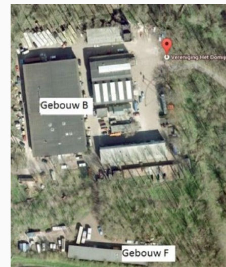
76. De eerste fase daken voor de zonnepanelen. Gebouw B en F.
