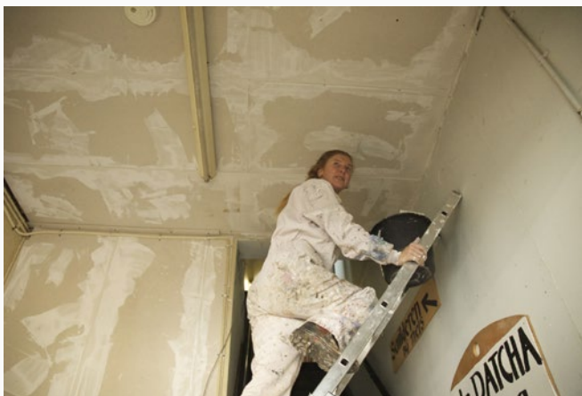
15. Brandwerende tussenmuren worden door de leden aangebracht. Foto Boogert fotografie.
